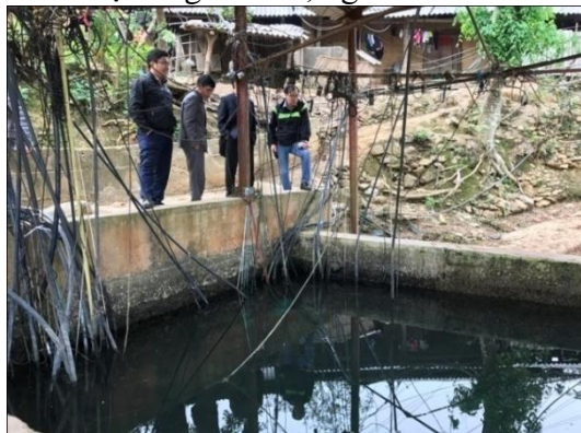
Hình 4. Công trình thu, trữ nước nước mạch ngầm tại Mường Khương, Lào Cai
