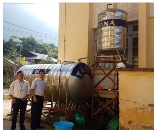
Hình 8. Thu trữ nước mưa UBND xã Sủ Pán - huyện SaPa - tỉnh Lào Cai
