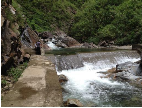
Hình 2. Đập dâng, cấp nước sinh hoạt xã Bản Bo, huyện Tam Đường, Lai Châu
