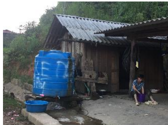
Hình 12. Téc nhựa chứa nước mưa tại xã Lũng Cải, huyện Bắc Hà, tỉnh Lào Cai
