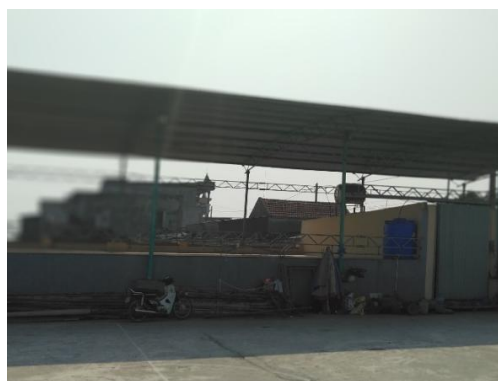
Công trình bể bơi có mái che
