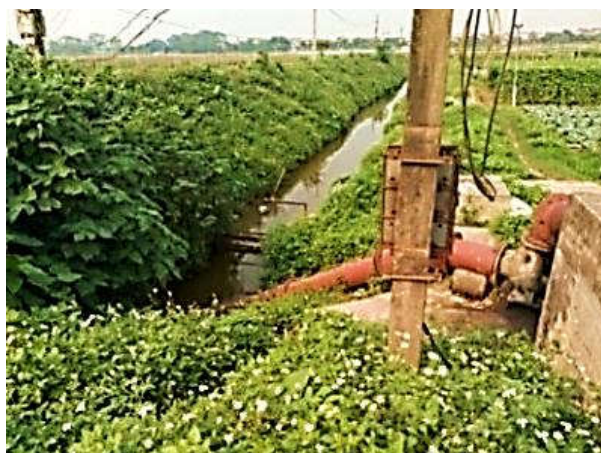
Hình 2: Trạm bơm dã chiến xã Văn Đức
