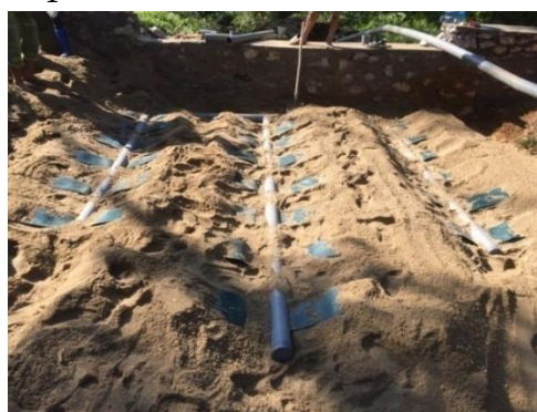
Hình 7. Lắp đặt hệ thống thu nước tại mô hình
