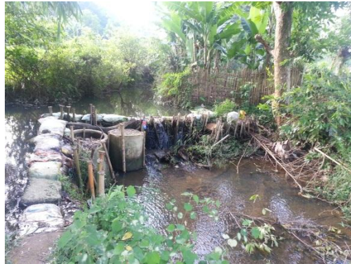
Hình 3. Những công trình tạm “không có chủ quản lý”.
